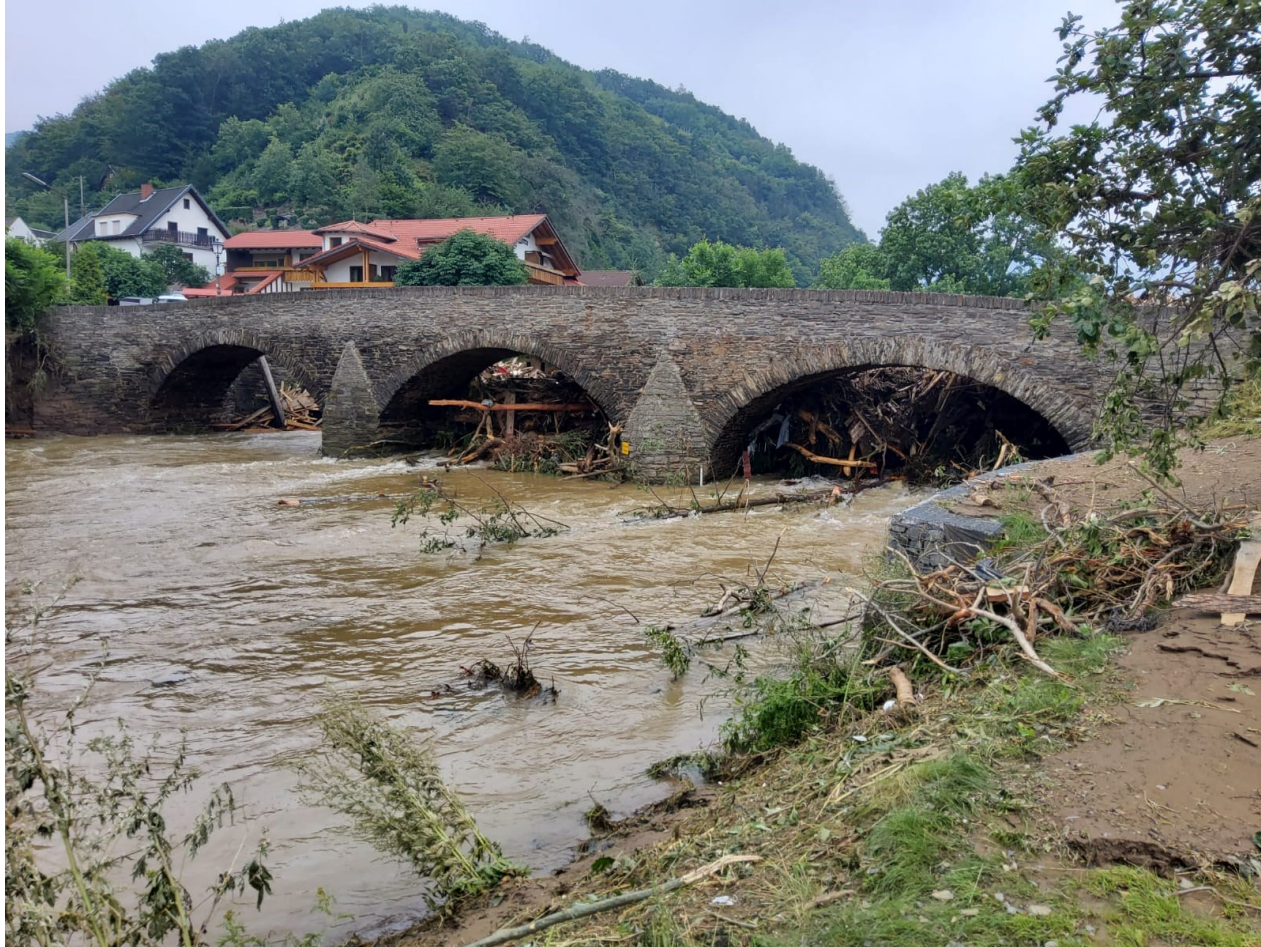
Verklauste Brücke in Dernau an der Ahr im Juli 2021 (Foto: Gronwald)
