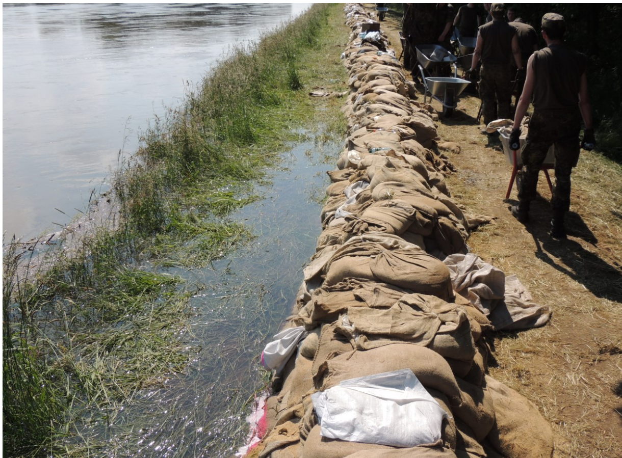
Elbe-Umflut-Kanal bei Pechau (Foto: Jüpner, 2013)
